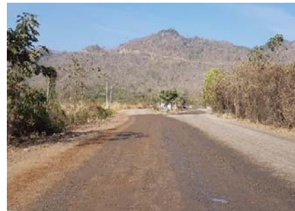
รูปที่ 2-9: การฉีดพรมน้ำบนเส้นทางขนส่งแร่
